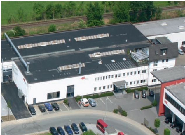
诺因拉德生产基地 Production premises Neuenrade
